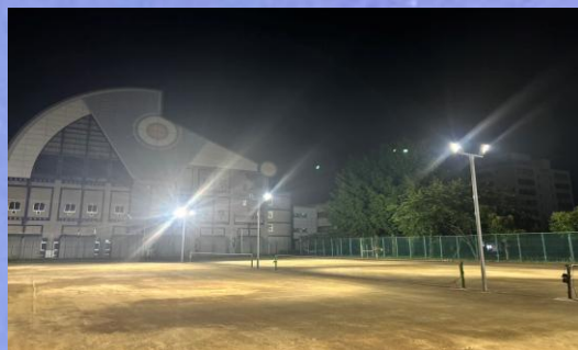
テニスコート照明設置
