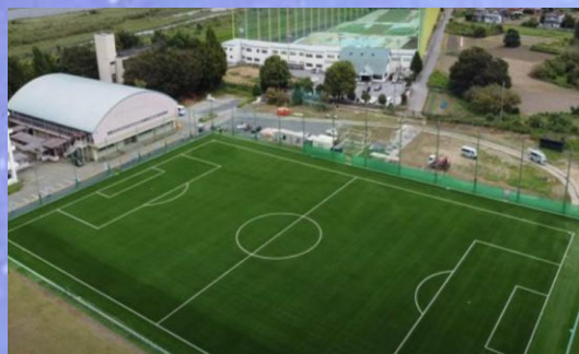
サッカーグラウンド 人工芝設置
