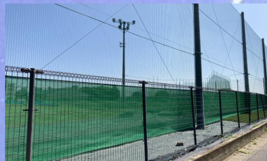
グラウンド防球ネット改修
